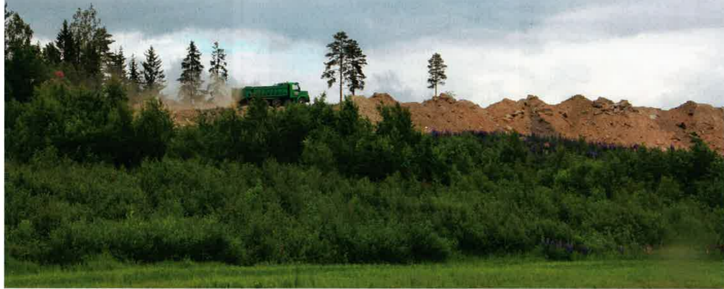
Rajamäen haulikkoratojen meluvallin rakentamisen loppuvaiheessa testattiin onnistuneesti myös sosiaalisen median voimaa tiedottamisessa.
